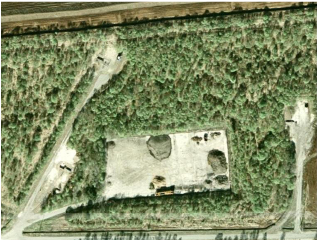
Abbildung 2 Luftbild der Pumpenstation
