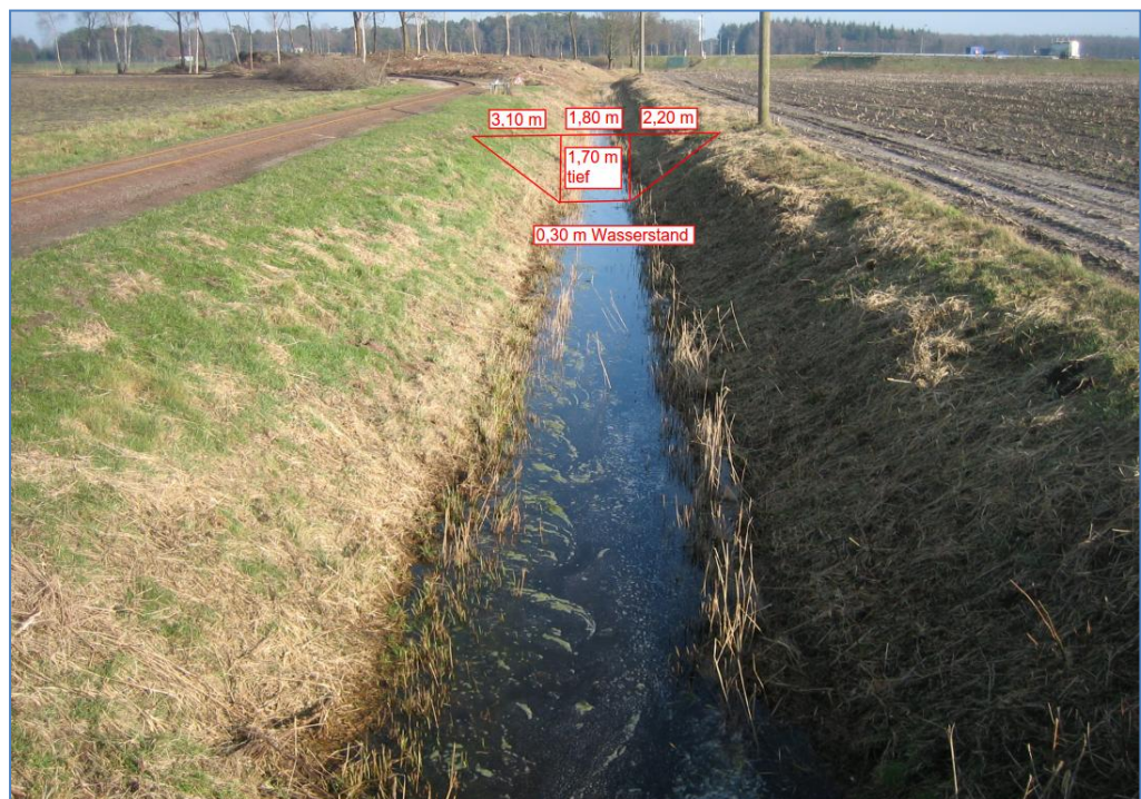
Abb. 5.1 Graben bei der Einleitstelle, vom 18.03.2015
