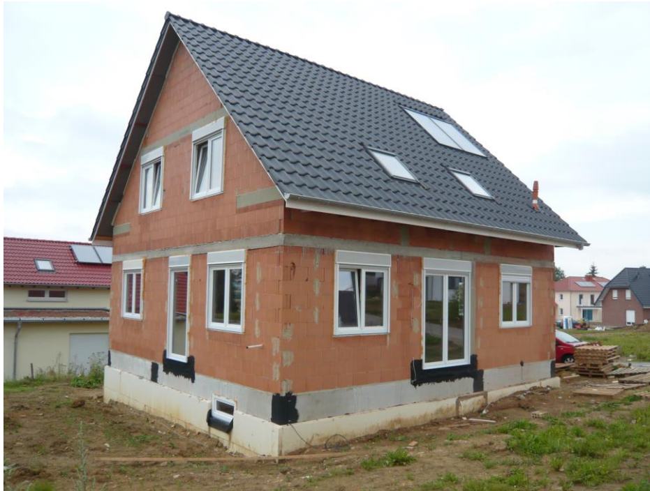
Abb. 8.3: Der Rohbau des EFH ist abgeschlossen („Weiße Wanne“ sowie Hochlochziegel im Erd- und Dachgeschoss); das Dach ist gedeckt und die Fenster sind eingesetzt.
