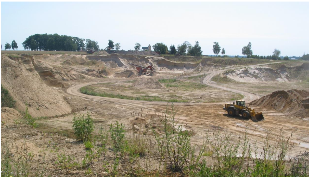
Abb. 5.1.5: Trockenabbau von Sand mittels Radlader im Landkreis Verden.
