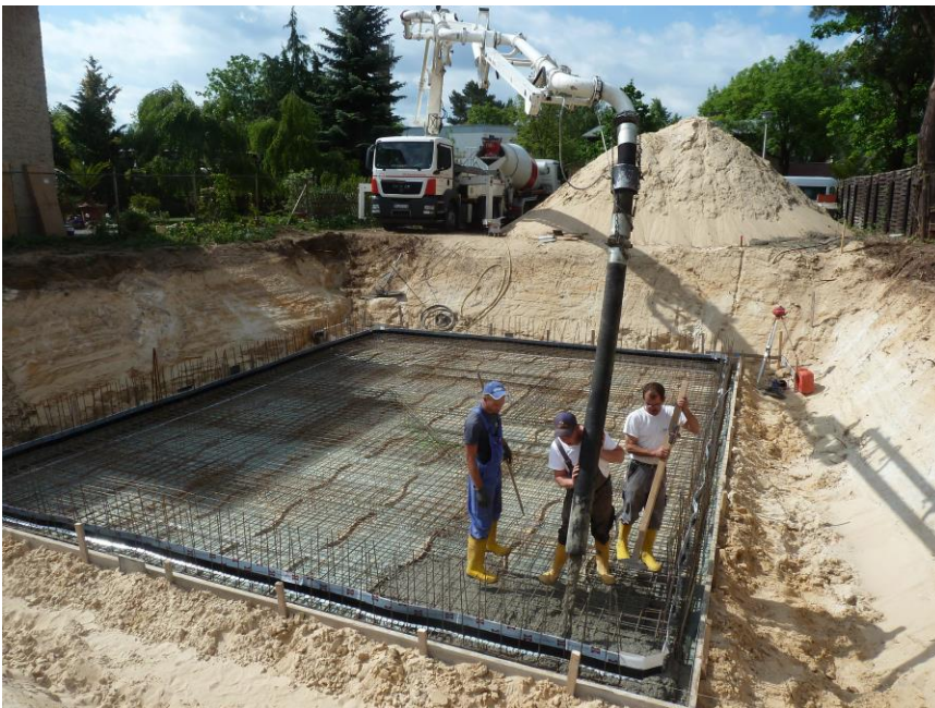
Abb. 8.2: Baugrube eines EFH mit aufgehaldeten Aushubmaterial (Sand). Herstellung der Beton-Bodenplatte mit Bewehrung (Betonstahl).
