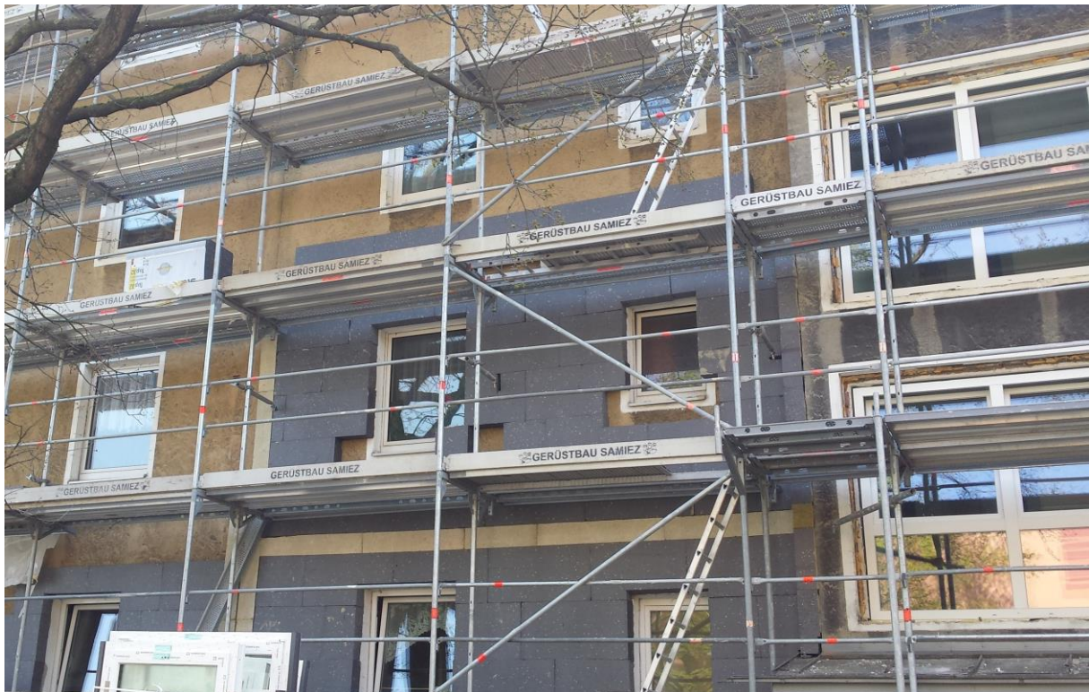
Abb. 4.4: Im Hochbau nehmen Bauleistungen im Bestand immer mehr an Bedeutung zu. Dazu zählt beispielsweise die energetische Modernisierung mittels Wärmedämmsystem.
