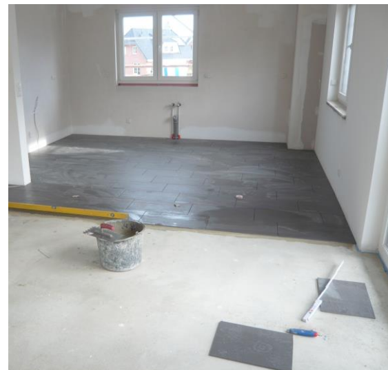
Abb. 8.4: Beim Innenausbau setzt sich der Verbrauch mineralischer Rohstoffe fort: Estrichmörtel als Untergrund für den Bodenbelag (Fliesen) und verputzte Innenwände.
