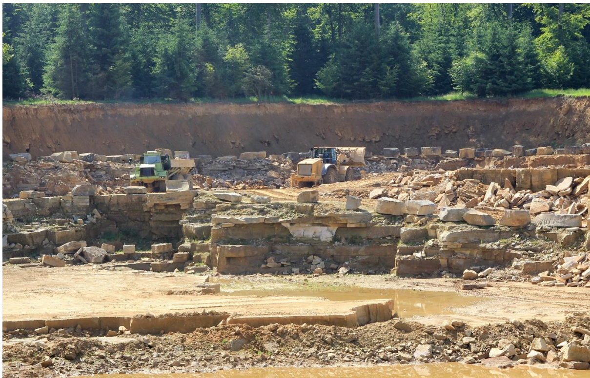
Abb. 5.6.6: Gewinnung von Rohblöcken des Oberkirchner Sandstein mittels Radlader und Dumper in einem Steinbruch in den Bückebergen.
