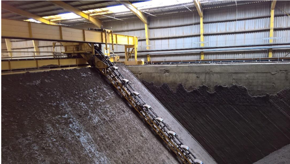
Abb. 5.2.2: Lagerung und Aufbereitung von Lauenburger Ton mittels Quersumpfanlage.
