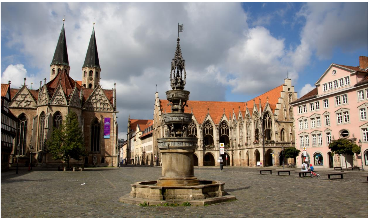
Abb. 5.6.1: Natursteinensemble am Altstadtmarkt in Braunschweig. Im Hintergrund rechts und links das Altstadttrathaus bzw. die Martinikirche. Während hier Elmkalkstein und Rogenstein verbaut wurden, besteht der achteckige Sockel und die ebenfalls achteckige untere Brunnenstufe des Altmarktbrunnens aus Velpker Sandstein, während für den mittleren Teil Salzhemmendorfer Dolomit eingesetzt wurde. Der obere Teil besteht aus Rammelsberger Blei.
