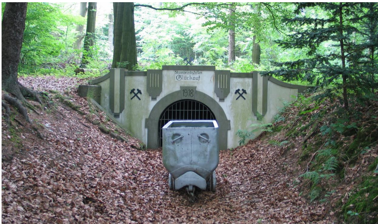
Abb. 7.12: Der Dörper Bergmannsweg verbindet Relikte des Steinkohlebergbaus zu einem Themenweg: Hier das Stollenmundloch des Steinbrinkstollens am Nesselberg.
