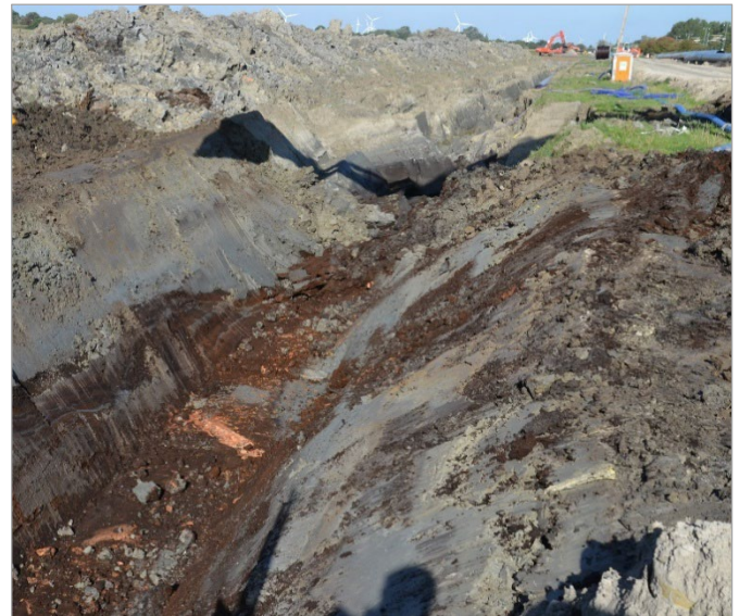
Abb. 5: Die Trennung des Bodenmaterials stößt gerade bei kleinräumigen Variabilitäten in der Mächtigkeit an Grenzen. Beispiel aus der Marsch mit eingeschalteten Niedermoor- torfen, aufgeschlossen in instabilem Leitungsgaben. Unten im Profil ist ein Baumstamm sichtbar (Foto: Hammerschmidt/Stadtman, LBEG).
