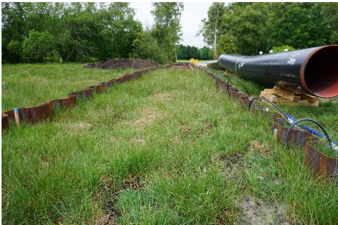
Abb. 7: Bauvorbereitung der Querung von Moorböden im offenen Graben auf einer Gasleitungsstrasse. Spundung und Einbringung von Lanzen zur Wasserhaltung (rechts; Foto: Hammerschmidt/Stadtmann, LBEG).
