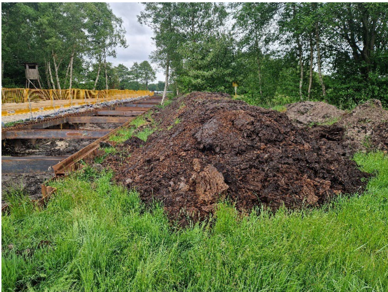
Abb. 11: Links in reißfestes Geotextil eingeschlagene Sandbaustraße, mittig mit Spundwänden und Gurtung gesicherter Leitungsgraben, der bis zum mineralischen Unterboden ausgehoben ist, mit Lanzen zur Entwässerung. Daneben Bodenmiete aus Hochmoortorf, ganz rechts sandiger Oberboden (Sanddeckkultur). Maßnahmen zum Feuchthalten des Materials stehen hier noch aus (Foto: Hammerschmidt/Stadtmann, LBEG).
