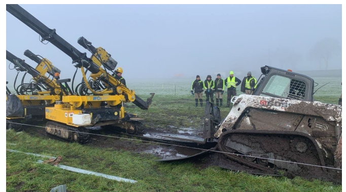
Abb. 4: Auch kleinere Maschinen auf Ketten können bei nas-sen Bedingungen einsinken, hier beim Bau einer Frei-flächen-Photovoltaikanlage (Foto mit freundlicher Ge-nehmigung von L. Kaper).
