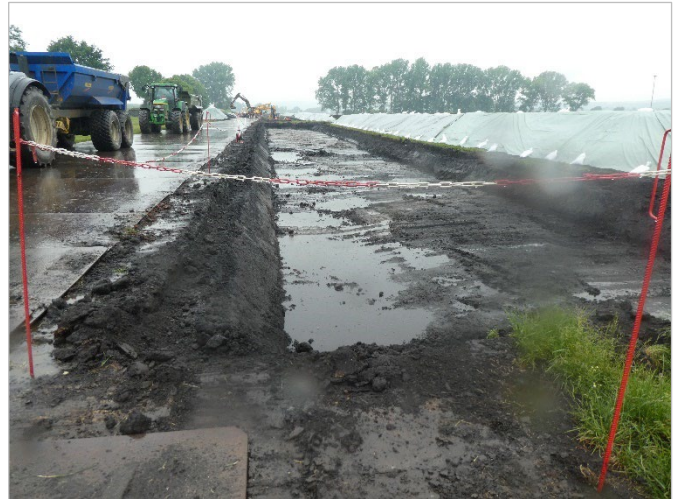
Abb. 8: Lastverteilungsmaßnahmen und Abdeckung der Bodenmitte mit Planen beim Leitungsbau im Niedermoor. Eine Sicherung der Planen gegen Wind kann ein Problem darstellen (Foto: Hammerschmidt, LBEG).
