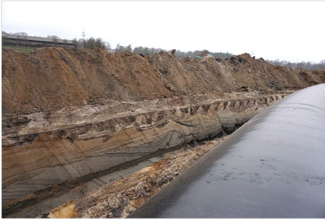
Abb. 6: Bei Umbruchböden ist eine Trennung der Sand- und Torfbalken nicht möglich (Foto: Hammerschmidt/ Stadtmann, LBEG).
