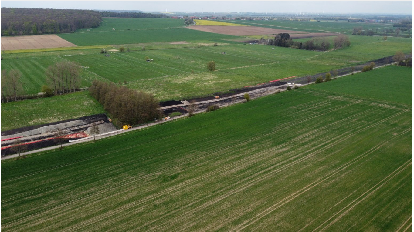
Abb. 1: Verlegung von Hochspannungserdkabeln durch Niedermoorböden in Südniedersachsen (Foto: Stadtmann, LBEG).
