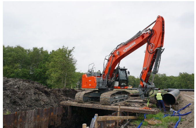
Abb. 9: Reduzierung der Bodenbefahrung und der beanspruchten Fläche durch die Platzierung von armierten Baggermatratzen quer auf den Spundwänden und „schwebende“ Arbeit des Baggers. So wird eine reduzierte Befahrung und der Lastabtrag in tiefere Schichten erreicht (Foto: Hammerschmidt/Stadtmann, LBEG).
