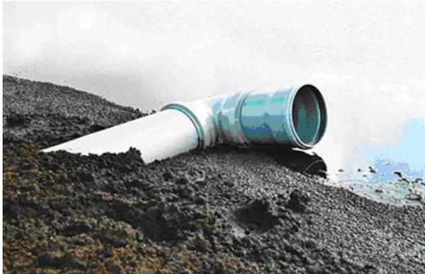
Abb. 8: Regelung der Wasserstände mit einem KG-Rohr und aufgesetztem Bogenrohr (J. Blankenburg)
