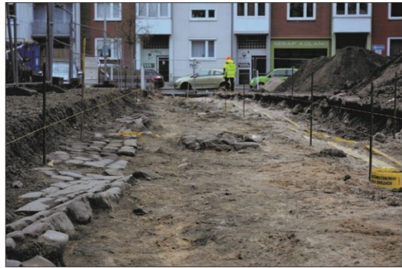
Abb. 22: Eindrücke aus der Bauausführung (Bildrechte: LBEG). Links: ausgehobene Pflanzgrube, rechts: verfüllter Leitungsgraben.
