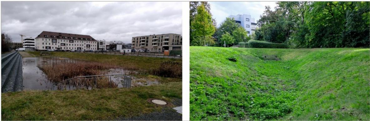
Abb. 21: Wasserrückhaltebecken, die bei Starkregenereignissen das Kanalnetz entlasten können (Bildrechte: LBEG).
