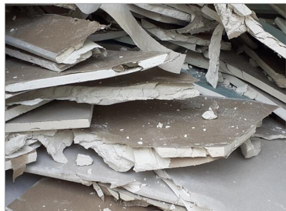
Abb. 9.5: Gipshaltige Bauabfälle, hier getrennte Sammlung von Bruch aus Gipskartonplatten auf einer Baustelle für ein Mehrfamilienhaus.
