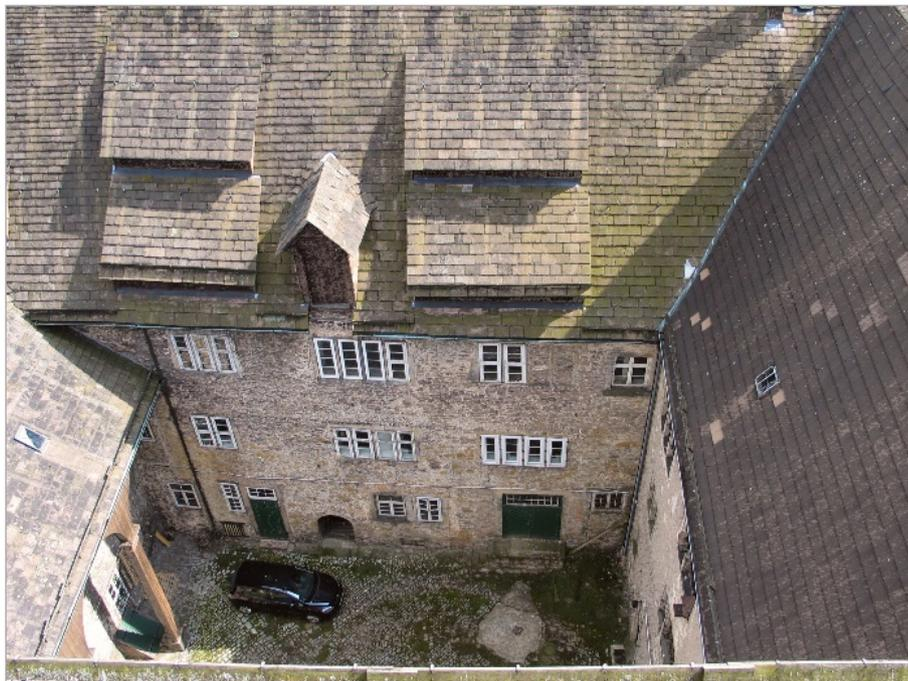
Abb. 5.6.2: Das aus einer mittelalterlichen vierflügeligen Wasserburg entstandene Schloss Grohnde an der Weser zeigt die früher intensive Nutzung und Langlebigkeit heimischer Naturwerksteine. Erkennbar sind ein mehrgeschossiges Mauerwerk aus Bausandstein (Wealden-Sandstein), eine Dacheindeckung aus Wesersandsteinplatten sowie Kopfsteinpflaster im Innenhof.
