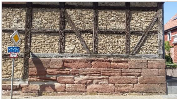
Abb. 5.6.3: Wirtschaftsgebäude bei Bad Gandersheim mit Sockel aus Sandsteinquadern (Roter Wesersandstein des Mittleren Buntsandsteins). Im darüber errichteten Fachwerk sind die Gefache mit vermauerten ungleichförmigen Kalksteinbrocken (Trochitenkalk des Oberen Muschelkalks) gefüllt.
