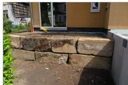
Abb. 5.6.8: Bei dieser Innenbebauung in Rhüden im Landkreis Goslar wurden die durch Rückbau der alten Hofstelle anfallenden Werksteine aus Hilssandstein wertgeschätzt und teils in die neue Terrassenanlage integriert. So bleibt, trotz Modernisierung, das durch Naturwerksteine geprägte historische Ortsbild bewahrt.
