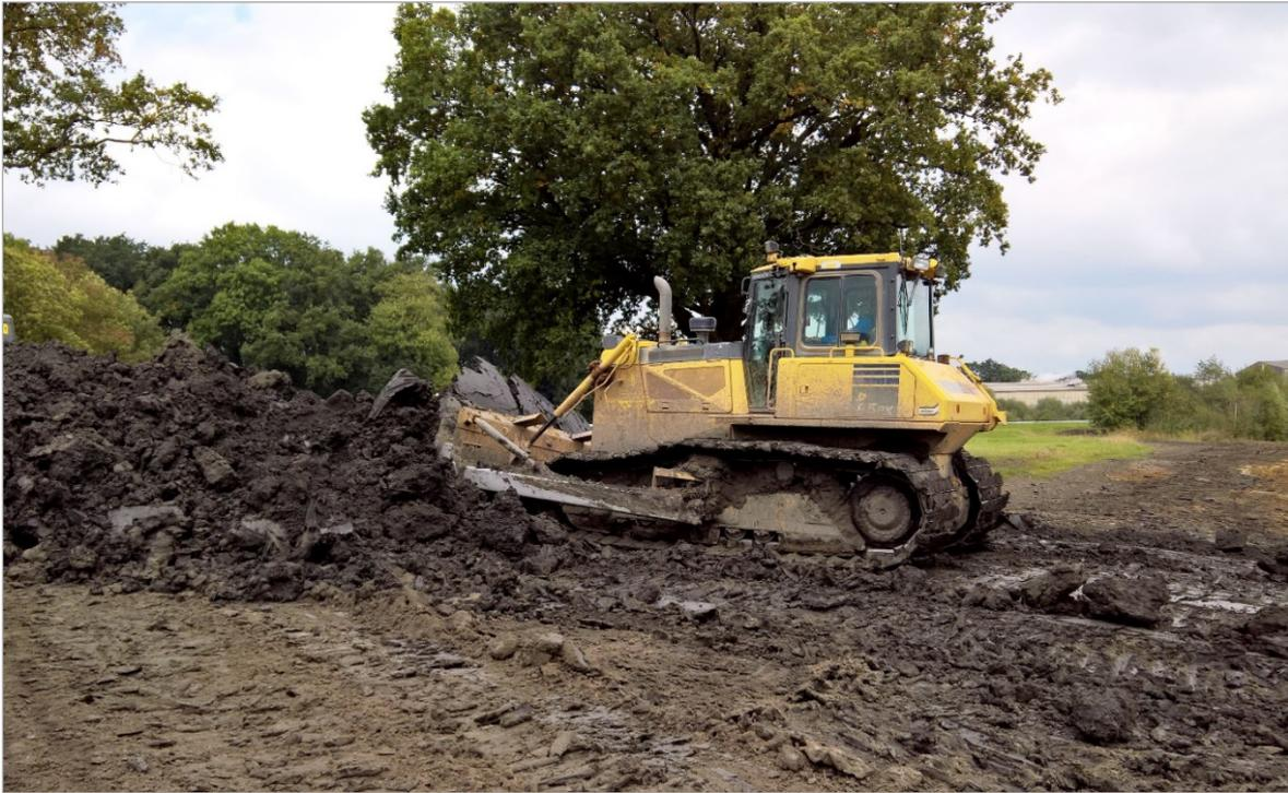
Abb. 5.2.5: Gewinnung der oberflächennahen Verwitterungsschicht des Lauenburger Tons in Ostfriesland.
