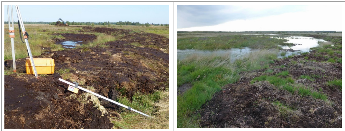
Abb. 4.4: Links: Moorbagger (Hintergrund) baut hohen Damm unter Zuhilfenahme eines Nivelliergerätes. Im vernässen Torfstich links haben sich bereits Torfmoose ausgebreitet (NSG Oppenweher Moor, 28.08.2013). Rechts: Derselbe Damm mit Anstauffläche und aufgeschwommenen Torfmoosen im folgenden Sommer (NSG Oppenweher Moor, 05.06.2014; Fotos: F. Niemeyer).
