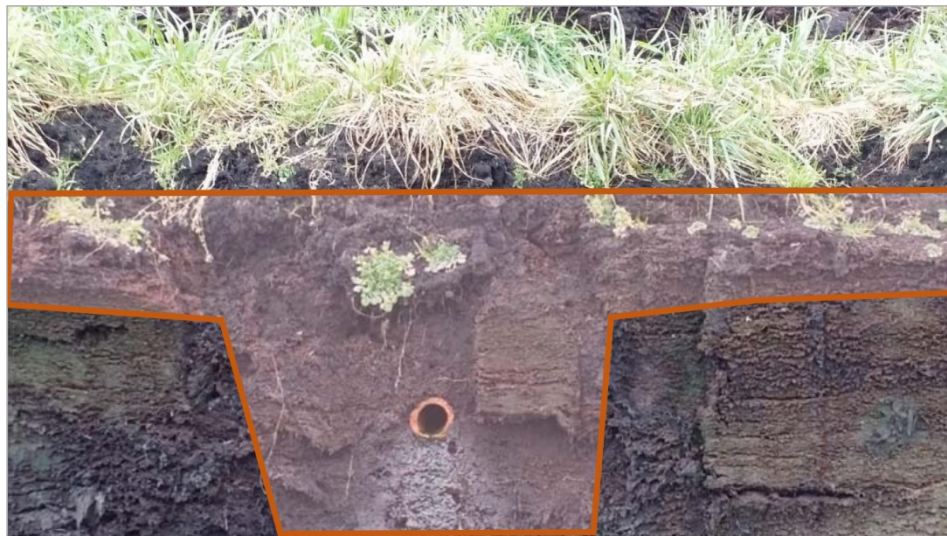
Abb. 6.2: Tondränungen im Querschnitt mit landwirtschaftlichem Oberboden auf der Oberfläche und im Drängraben (Foto: Hofer & Pautz GbR).
