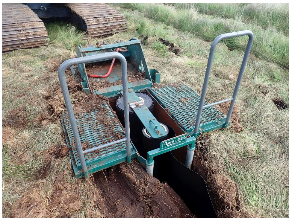
Abb. 4.16: Ein Schlitzpflug im Einsatz (Foto: A. Bretschneider und H. Mordhorst-Bretschneider).
