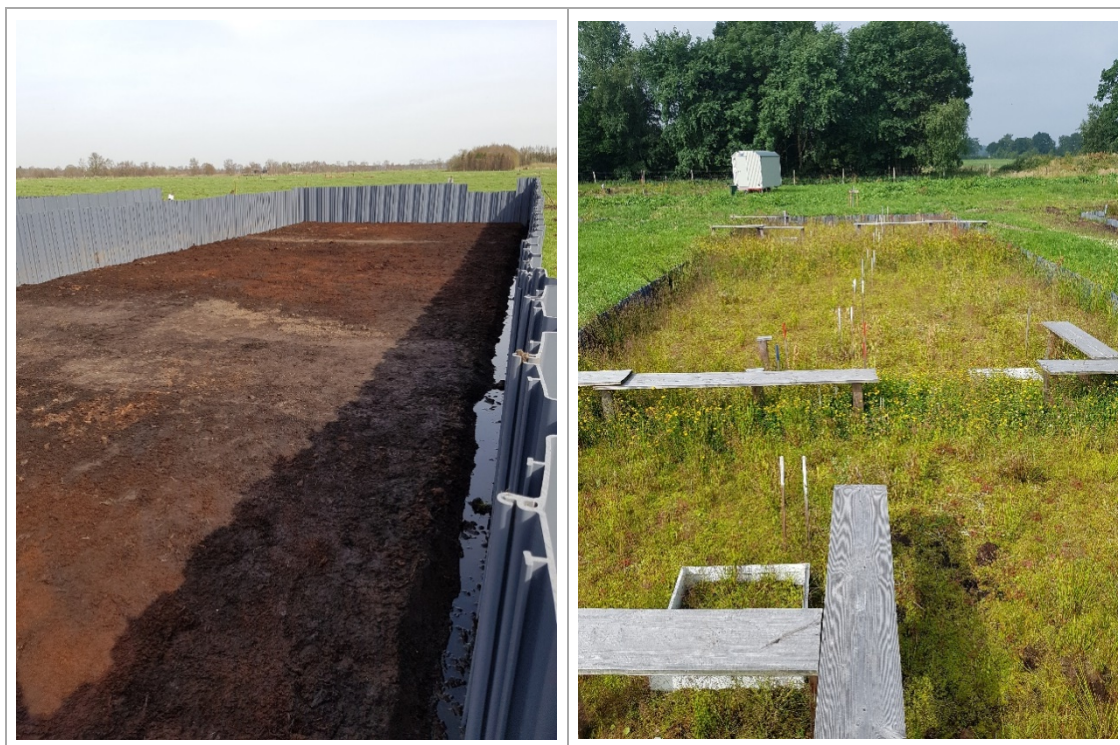
Abb. 6.7: Oberbodenabtrag mit verbleibenden Dränstreifen – OptiMoor (Fotos: Hofer & Pautz GbR). Links: Variante 4 „Oberbodenabtrag 30 cm“ bei Flächeneinrichtung März 2017, rechts: Variante 5 „Oberbodenabtrag 30 cm mit Torfmoosbeimpfung“ im Juni 2018 (vgl. Abb. 6.9). Die Dränstreifen zeichnen sich in der ansonsten geschlossenen Torfmoosdecke deutlich durch die Keimung von Grünlandvegetation ab (v. a. Hahnenfuß und Binsen).
