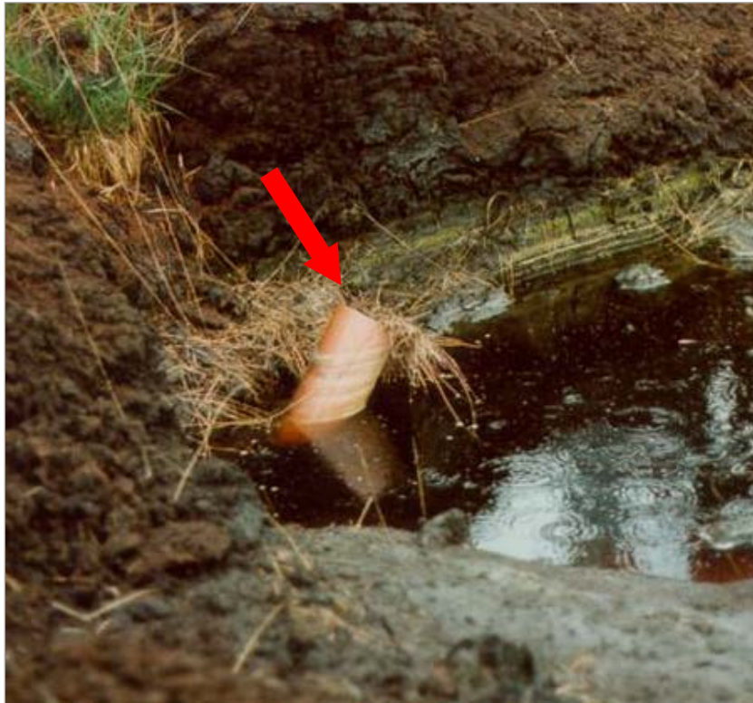
Abb. 4.14: Überlaufrohr mit Vegetationsresten am Einlauf (Foto: J. Blankenburg).
