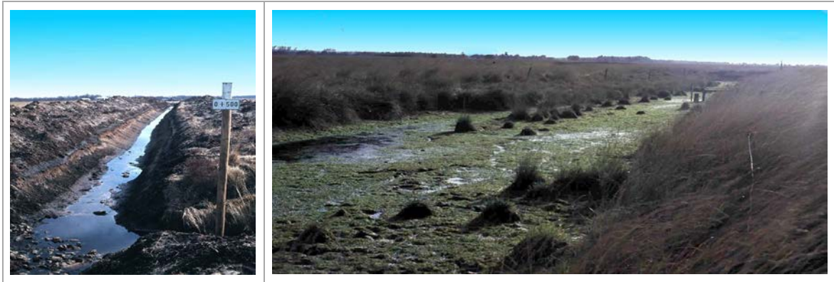
Abb. 4.13: Links: Aufgereinigter Graben im Leegmoor vor dem Verfüllen mit Torf. Rechts: Graben im Leegmoor, einige Jahre nach dem Verfüllen mit Torf (Fotos: J. Blankenburg).
