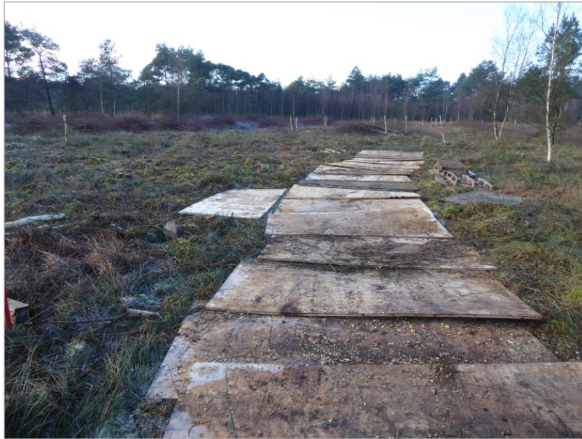
Abb. 4.2: Baggermatten zur Lastverteilung und Schonung der Kraut- und Moosschicht (LK Osterholz, NSG Heilsmoor; Foto: L. Kulp).
