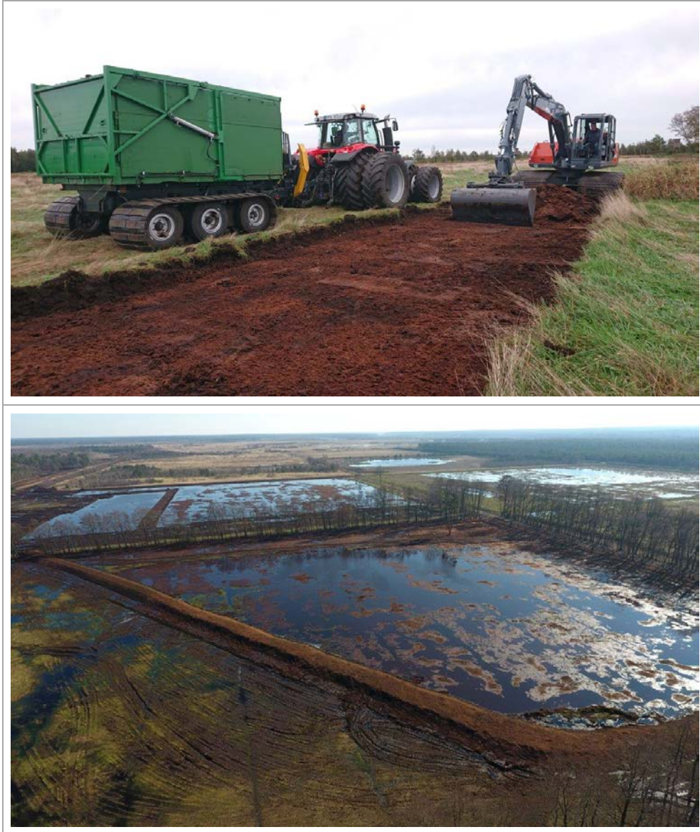
Abb. 6.6: Oben: Teilabtrag des landwirtschaftlichen Oberbodens mit Hydraulikbagger und Moor-Kübelraupe, unten: Der abgetragene Oberboden eignet sich für Dämmebau (Lichtenmoor, Fotos: T. Beuster).
