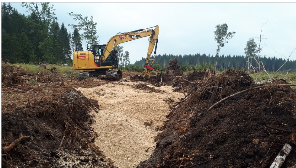
Abb. 7.1: Sägemehl wird im Bergland für die Verfüllung der Gräben benutzt (Foto: U. Schlette, Forstamt Neuhaus).
