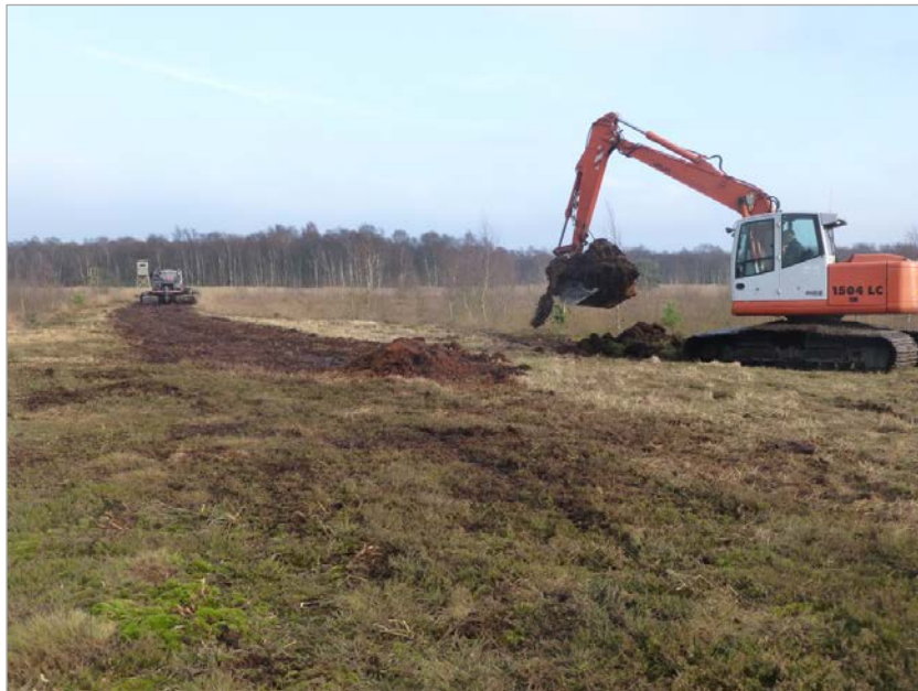
Abb. 4.6: Moorbagger fördert am vernässten Torfstichrand Torf für Moorraupe (Pistenbulli), die einen Torfdamm quer über einen Moorweg als Staukörper aufbaut (NSG Rehdeener Geestmoor, 26.11.2014; Foto: F. Niemeyer).
