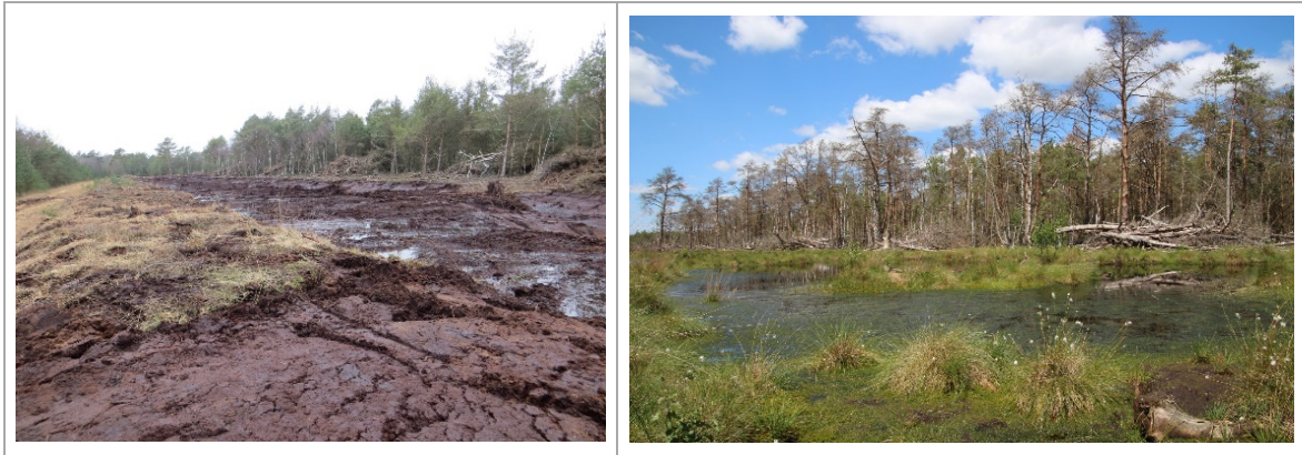
Abb. 4.8: Links: Bau einer überhöhten Verwallung (NSG Holtorfer Moor, LK Nienburg/Weser, 2015). Torfentnahme oberhalb des Walls, Wall abgedeckt mit Vegetationssoden. Im Vordergrund noch nicht abgedeckter Torfwall. Der Wall verläuft auf einem ehemaligen Graben, Entnahmekuhlen abgerückt und nicht durchgehend. Rechts: Blick von der Verwallung aus dem vorherigen Bild, 5 Jahre nach Bau. Das eingestaute Wasser reicht bis zum Damm, Torfmoose und Wollgräser breiten sich aus, Bäume sterben ab (NSG Holtorfer Moor, LK Nienburg/Weser, 2020; Fotos: T. Beuster).
