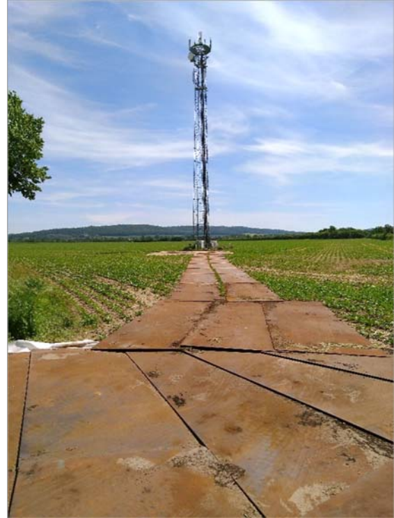
Abb. 6: Links: Unsachgemäßes Befahren einer zukünftigen Versickerungsmulde (Foto: U. Hammerschmidt). Rechts: Stahlplatten zur Vermeidung von Bodenverdichtung bei Arbeiten an einem Mobilfunkmast (Foto: R. Stadtmann).
