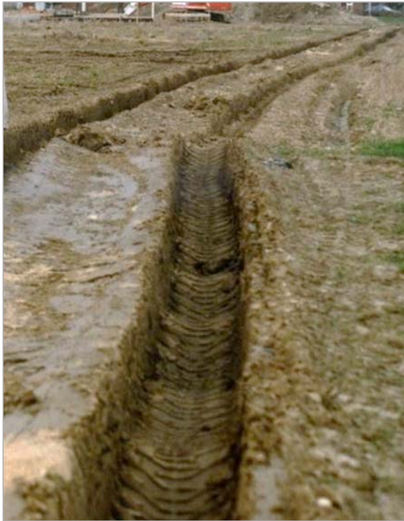
Abb. 6: Links: Unsachgemäßes Befahren einer zukünftigen Versickerungsmulde (Foto: U. Hammerschmidt). Rechts: Stahlplatten zur Vermeidung von Bodenverdichtung bei Arbeiten an einem Mobilfunkmast (Foto: R. Stadtmann).
