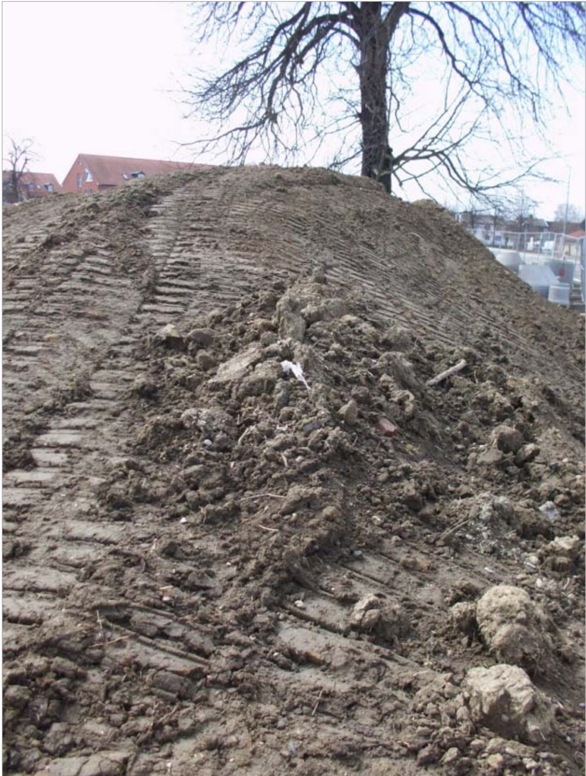
Abb. 8: Befahrene Oberbodenmiete. Boden wird verdichtet, erhöhte Erosion (Foto: U. Hammerschmidt).
