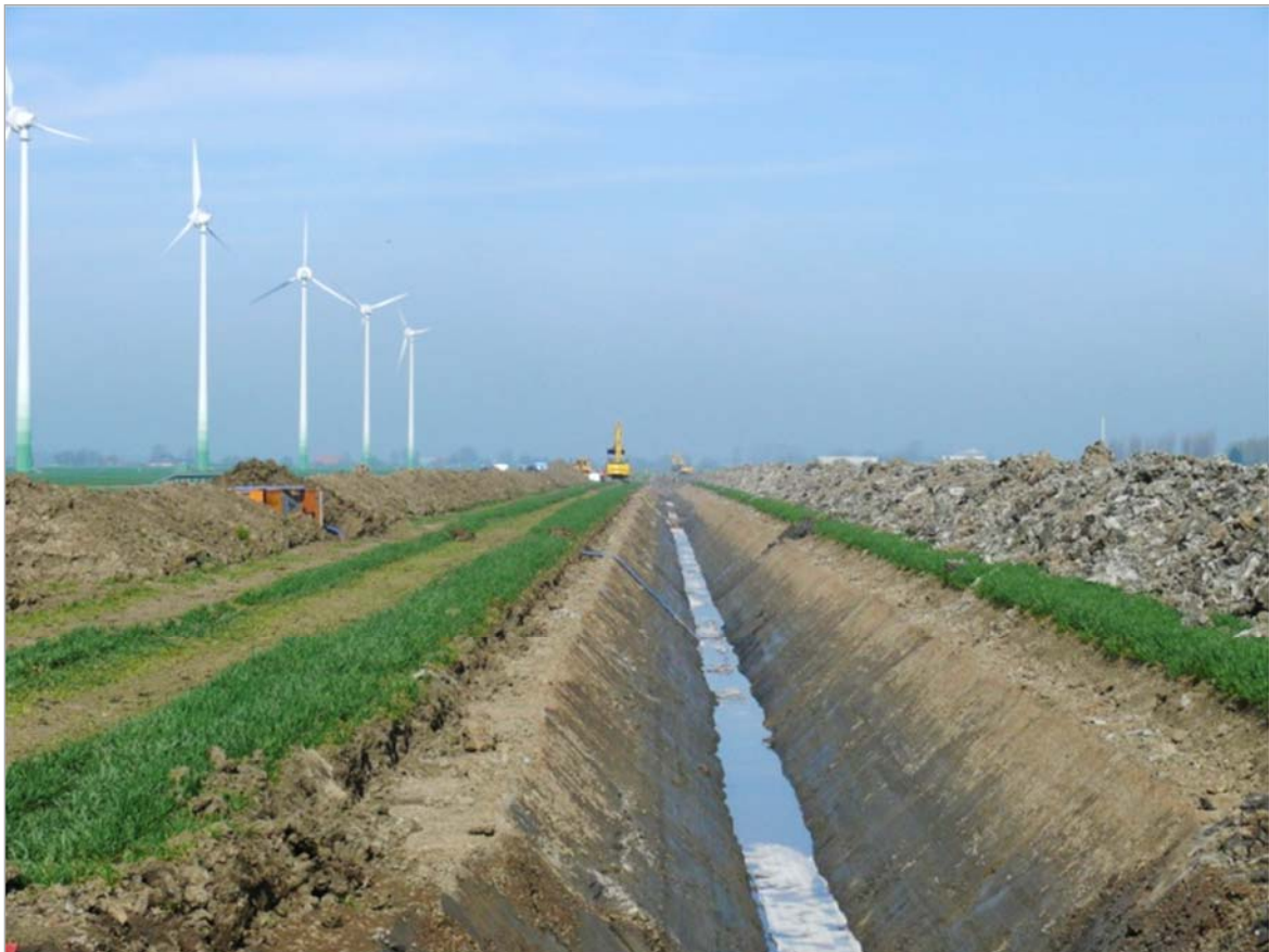
Abb. 1: Erdkabeltrasse in Niedersachsen (Foto: U. Hammerschmidt).
