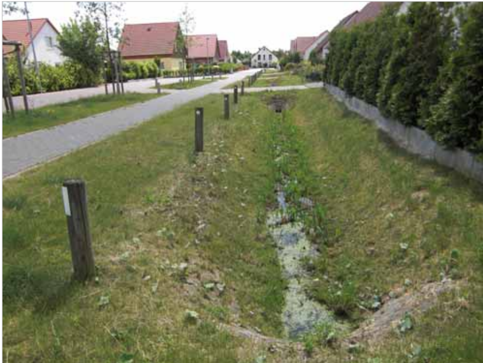
Abb. 43: Beispiel für die Zuführung des Niederschlagswassers von verschiedenen Flächen in einen offenen Graben. Foto: Nix, LBEG.
