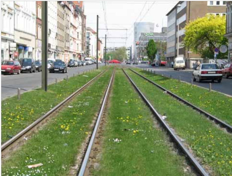
Abb. 51: Beispiel für die versickerungsfreundliche Gestaltung von Gleisanlagen. Foto: Bolze, LBEG.
