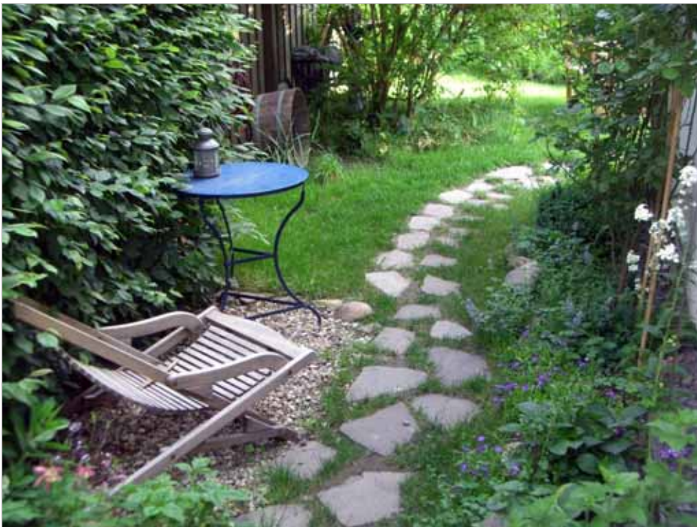
Abb. 46: Beispiel für die versickerungsfreundliche Gestaltung eines Gartenweges und einer Sitzcke. Foto: Steininger, LBEG.
