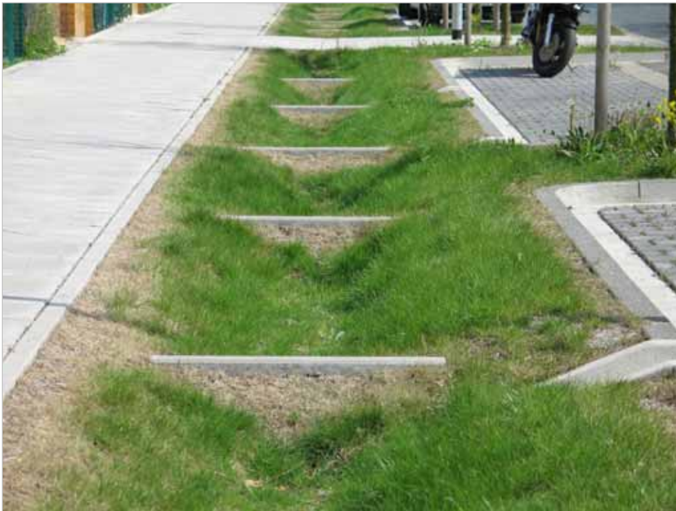
Abb. 39: Beispiel für eine Muldenversickerung mit Muldenunterbrechungen zum Ausgleich des Geländegefälles.
