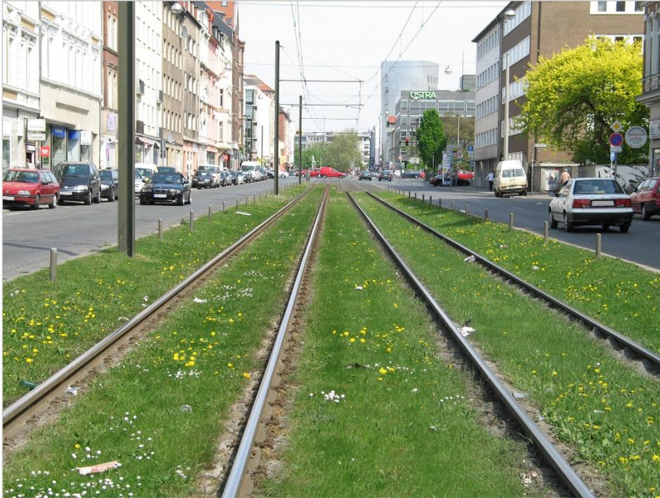
Abb. 39: Beispiel für die Teilentsiegelung von Gleisanlagen.
