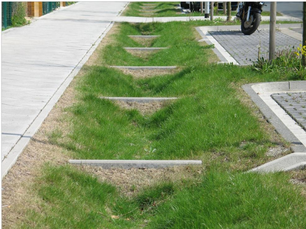
Abb. 27: Beispiel für eine Muldenversickerung mit Muldenunterbrechungen zum Ausgleich des Geländegefälles.
