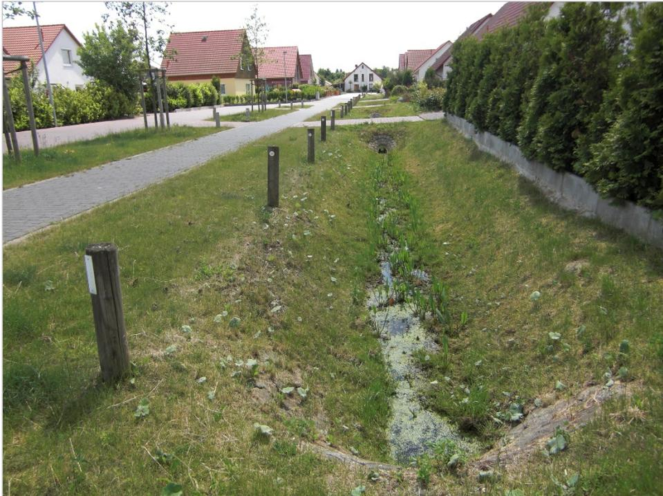
Abb. 31: Beispiel für die Zuführung des Niederschlagswassers von verschiedenen Flächen in einen offenen Graben.
