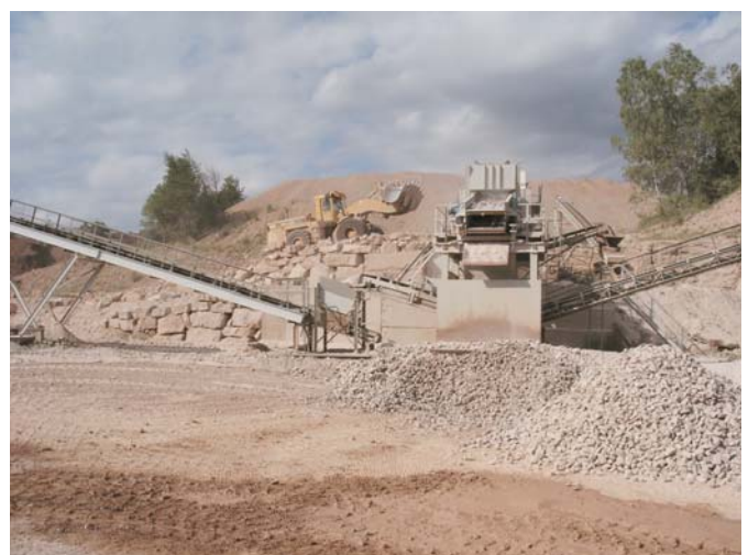
Abb. 4: Brecheranlage in den Nüxeier Dolomitbrüchen (Foto: H.-G. Röhling)
