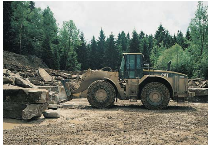
Abb. 2: Abbau der Sandsteinplatten mittels Radlader: Herauslösen der großformatigen Steinblöcke an den Schichtgrenzen
