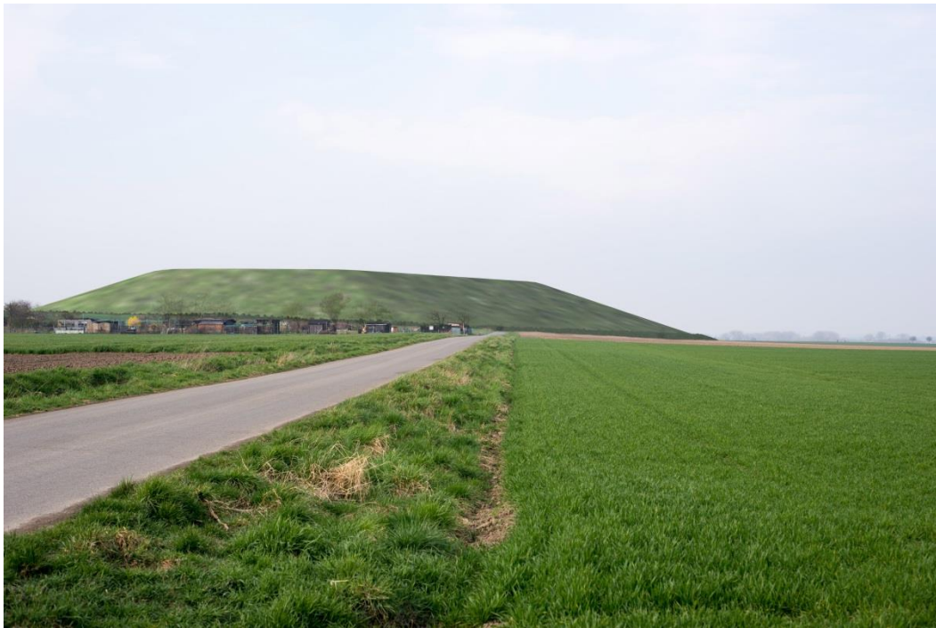
Abb. 43: Abgedeckte Neuhalde (Blickrichtung Westen)
