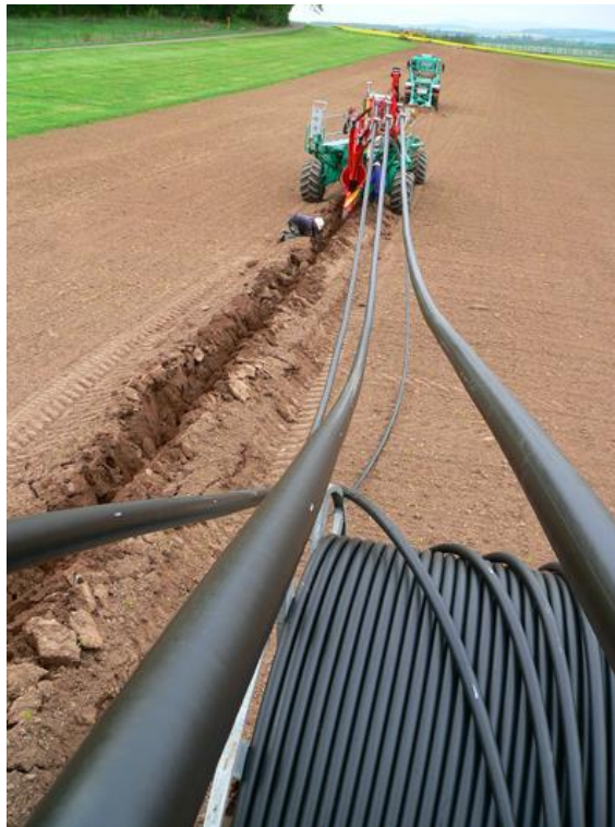
Abb. 20: Beispiel Kabelverlegung (Quelle: www.verlegepflug.at )
