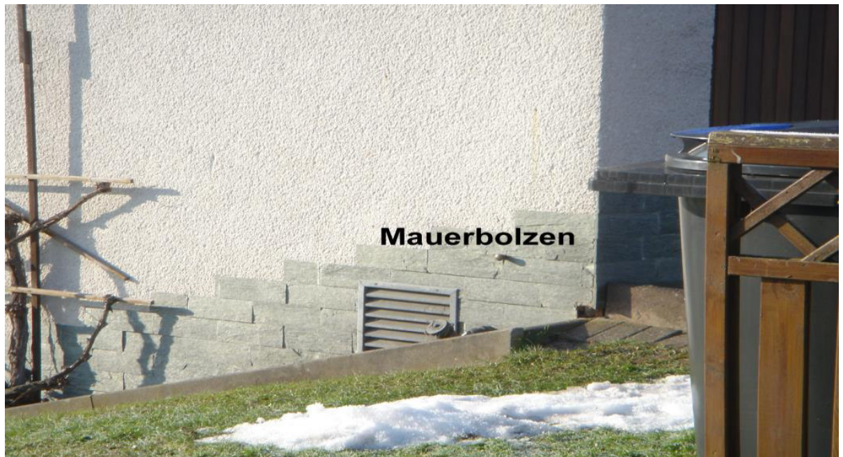
Abb. 3 Bolzen an einer Hauswand
