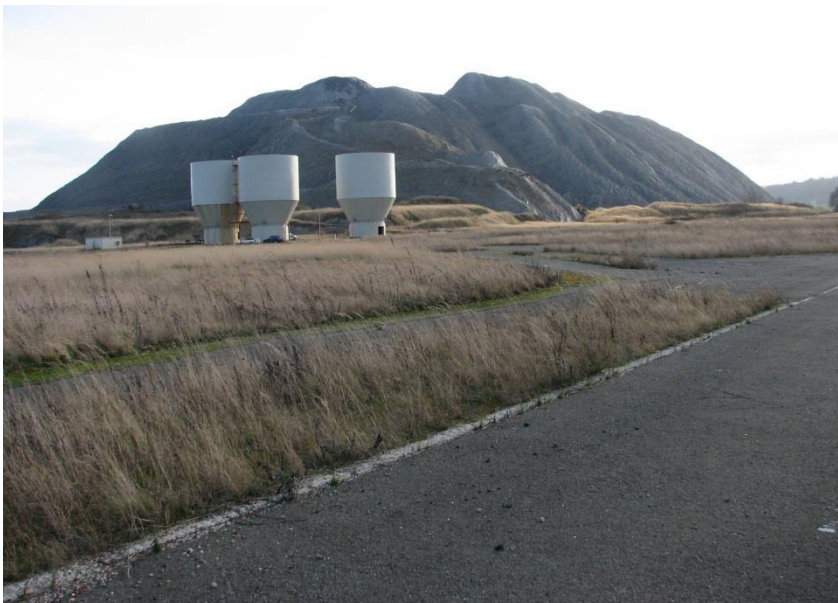
Abb. 6 Intze-Tanks an der Althalde
