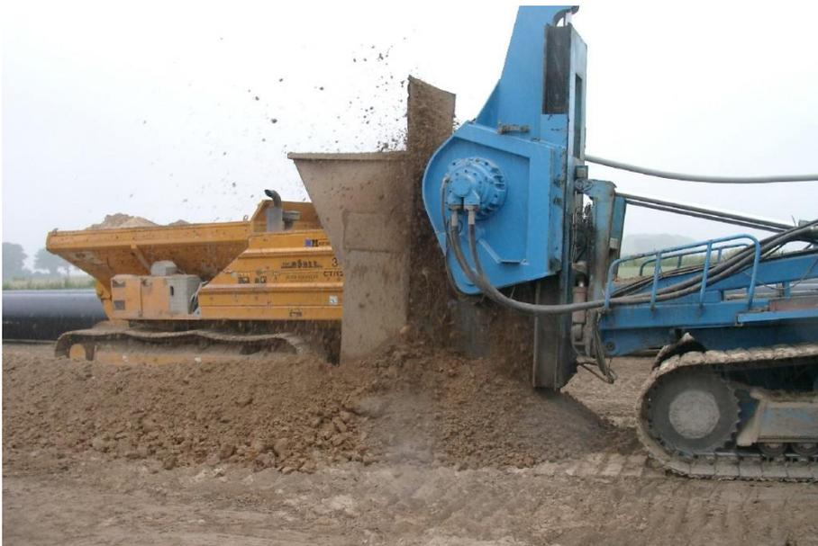
**Abb. 9 Einfräsen des Horizontaldräns**
