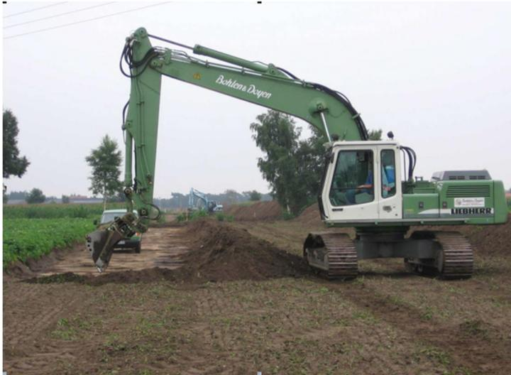
**Abb. 3 Mutterbodenabtrag**
