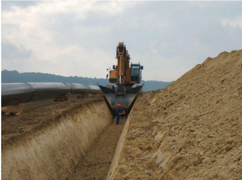
**Abb. 10 Rohrgrabenaushub**
