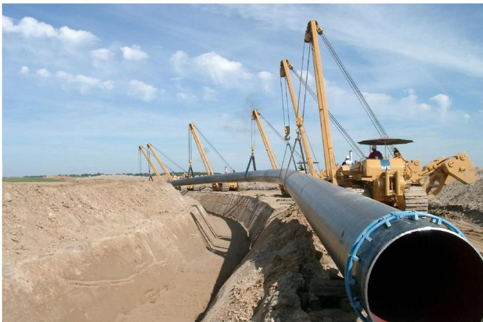
**Abb. 11 Absenken des Rohrstranges**
