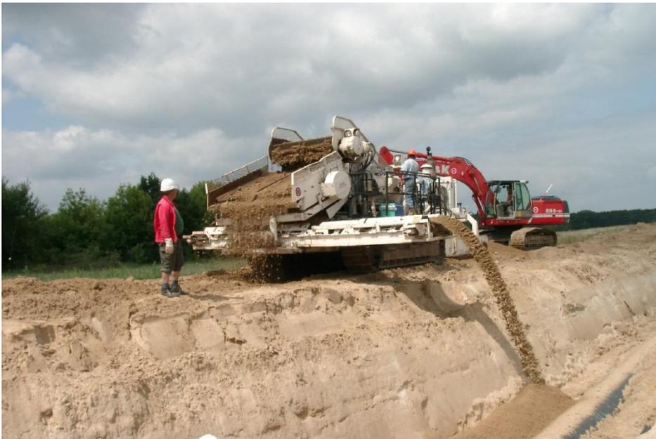
Abb. 12 Verfüllen mit steinfreiem Aushub im Bereich des Rohres
