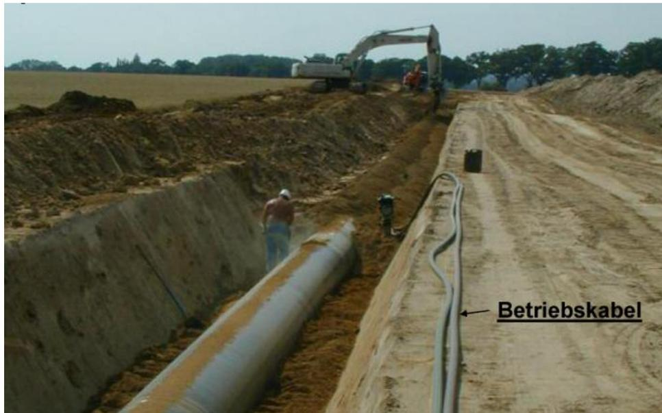
**Abb. 13 Rohrgrabenverfüllung**
