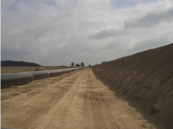
**Abb. 5** ausgefahrene Rohre
