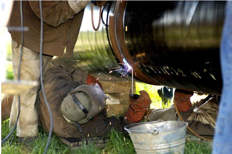
**Abb. 7 Verschweißen der Rohre**
