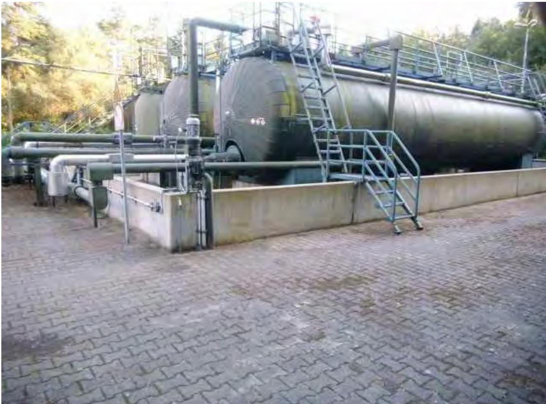
Bild 2: Tanks in Betoneinfassung
